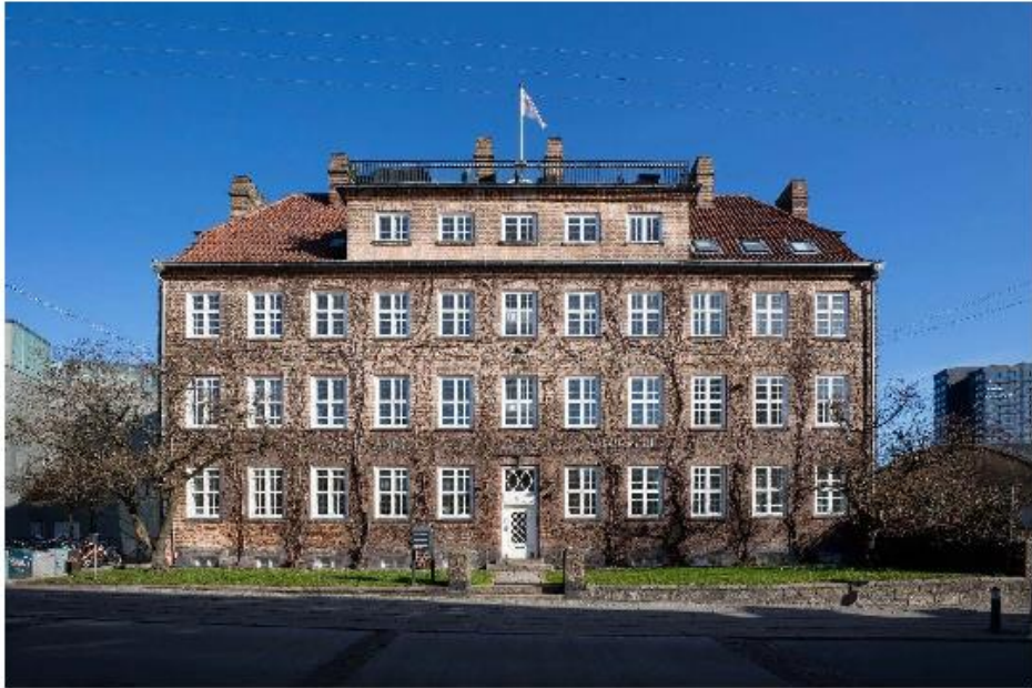
Den Gamle By i Aarhus er kendt for at bevare historiske huse fra en svunden tid. Men i resten af byen får Aarhus kritik for at være for hurtig til at tillade nedrivninger til fordel for nybyggeri. Her ses Baumannhuset fra 1910. Bygningen er nu fredet. Den blev ombygget og restaureret i 2006. De to nederste etager rummer DGI-husets spinning- og fitnessområde. Foto: Slig Nørhald, Ritzau Scanpix
