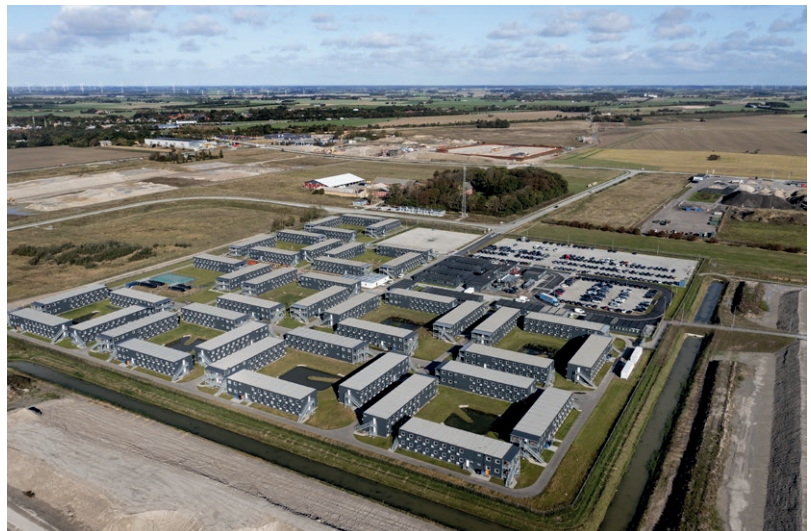
Tunnelbyen opført ved byggepladsen for den faste forbindelse mellem Danmark og Tyskland. FOTO: SUND & BÆLT
