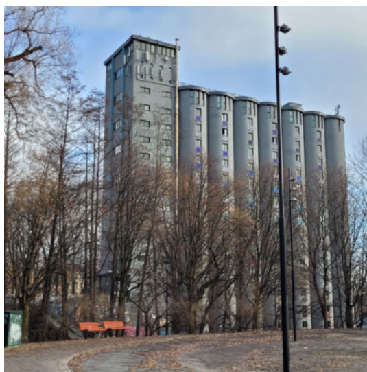
● Silo omdannet til boliger i Oslo.
