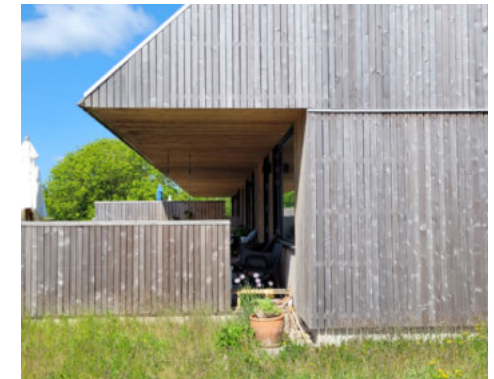
● Boliger i Nye ved Aarhus. Moderne arkitektur i træ af Loop Architects.
