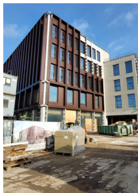
● Statens kontorbyggeri "Woodhub" i Odense opføres under "Den frivillige bæredygtighedsklasse" og er det hidtil største byggeri med trækonstruktion i Danmark. Arkitekt: C F Møller Architects
