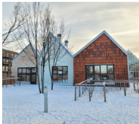
● Børneinstitution i Gladsaxe med direkte genbrug af materialer fra nedrevne bygninger på stedet - af Lendager.
