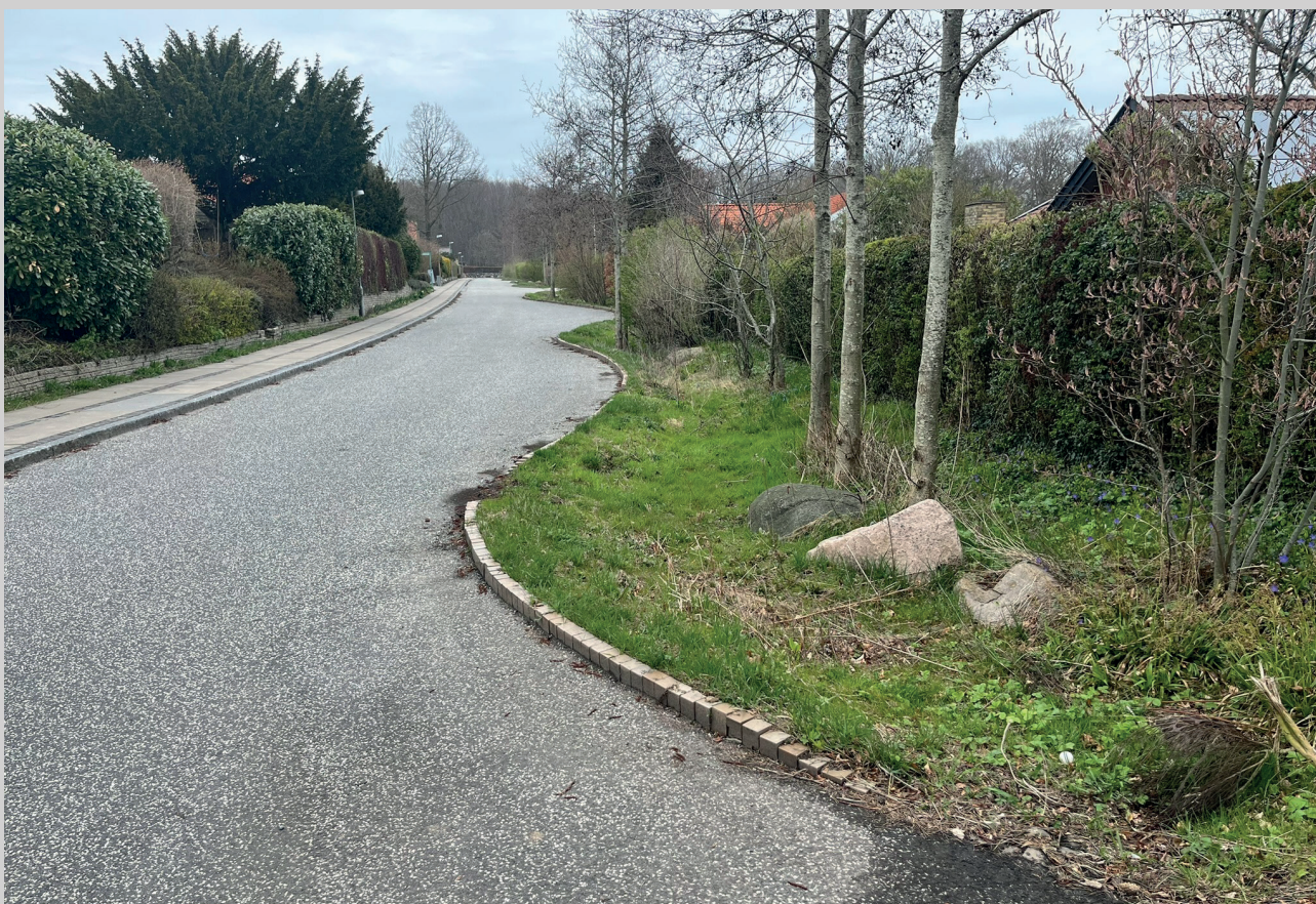
Figur nr. 5.3. LAR-løsninger i åben-lav områder tager plads og kræver pleje, men kan også give kvaliteter, selv en lidt kedelig forårsdag. Regnbede, Karensvej i Middelfart. Foto: Anne Madsbjerg, Københavns Universitet.
