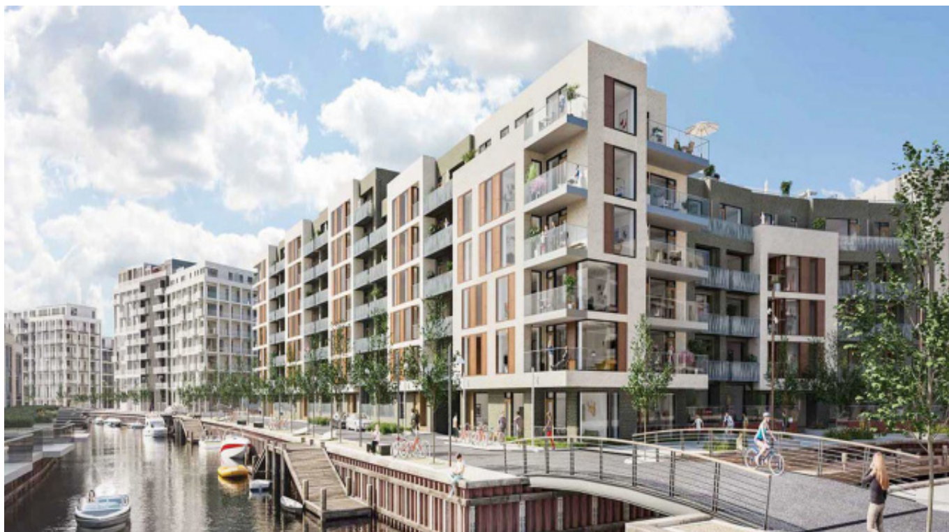
Nybyggeri på Teglholmen i Københavns Sydhavn
