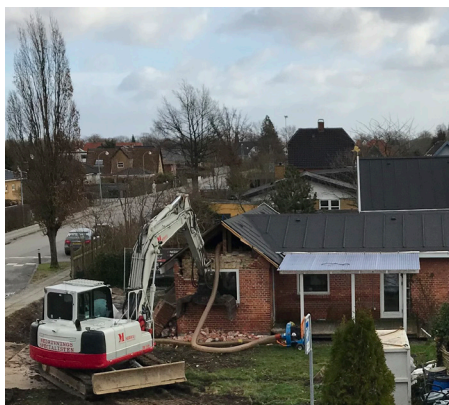
Nedrivningsprocessen i gang
