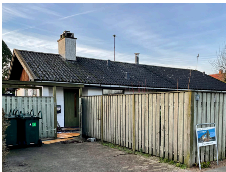
Gasbetonhus til nedrivning
