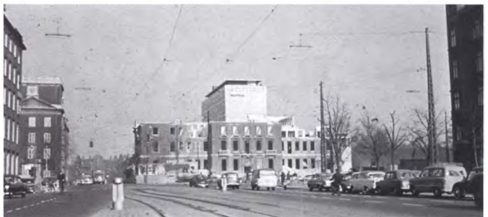
H.C. Andersens Boulevard ved Jar-mers Plads. 'Østifterne' under ned-rivning i 1962.
