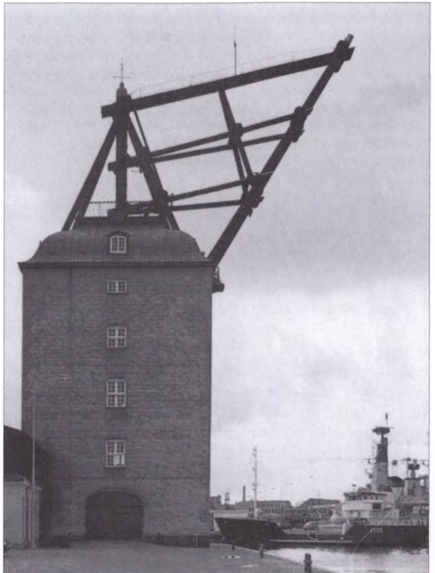
Mastkranen på Holmen.
