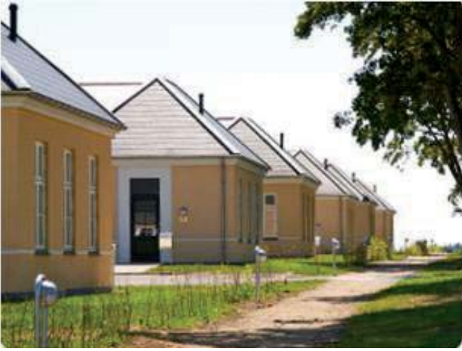
Figur 8. Belægningsbygninger efter udvendig efterisolering
