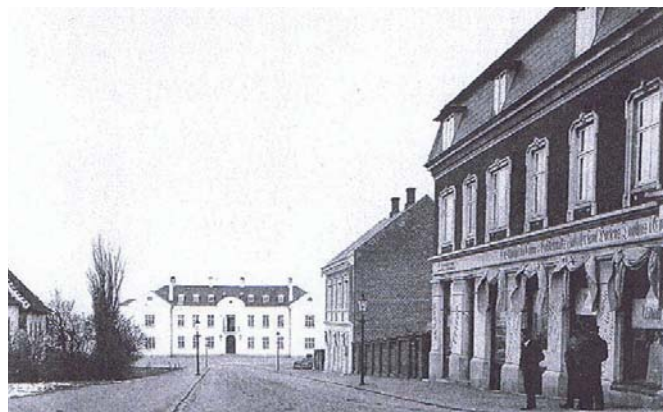
Figur 2. Den statelige stationsbygning i Ebeltoft, tegnet af H. Wenck i 1901, nedrevet omkring 1960
