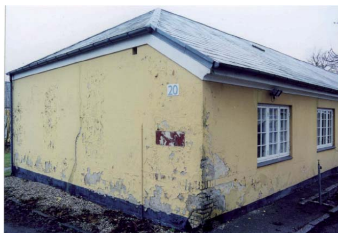
Figur 7. Belægningsbygning ved forsvarets flytning
