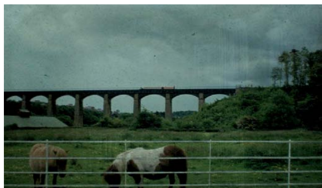
Figur 6. Aquadukt til transport af kulbåde i Llangollen i Wales. I dag bruges den til transport af turister
