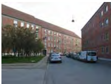
Fig. 8. Bangersgade totalt domineret af ensrettet nybyggeri.
