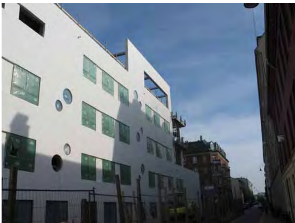
Fig. 32. Og det sidste skud på stammen, Københavns kommunes institutionsbyggeri i Eskildsgade, tegnet af TNT Arkitekter. Her har man sparet på gesimserne og er arkitektonisk parat til at bryde med det hele.
