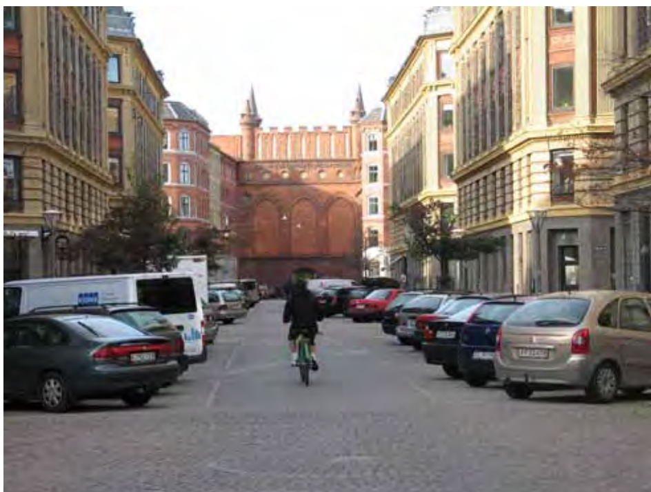
Fig. 27. Skydebanegades tætte spekulationsbyggeri fra 1892, udført som en meget markant helhed med masser af facadeudsmykning mod gaden. Før handlingsplanen havde der været oplæg fremme om at skære bunden af stikgaderne, for at få mere lys og luft. I stedet valgte man en total bevaring og istandsættelse – oven i købet i den dyre ende.
