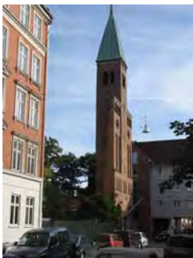
Fig. 14. Efter nedrivning af store dele af Saxogade kom Apostelkirkens tårn til at stå mærkeligt alene.
