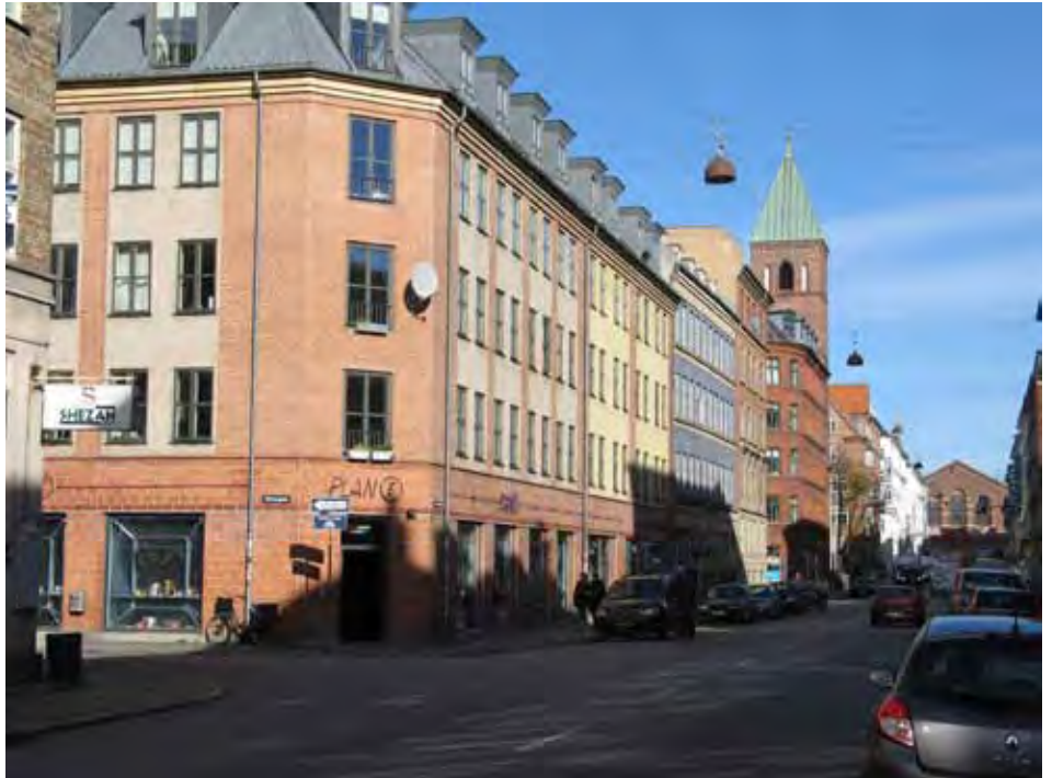
Fig. 29. Et usædvanligt nybyggeri på hjørnet af Istedgade og Viktoria-gade – ja, det er nybyggeri tegnet af Vilhelm Lauridsens Tegnestue. Muro-projektet med 30 almene to- og trerumsboliger, opført i 1999 i 'fuldmur'. I byfornyelse går det forhåbentligt ikke hen og bliver den vildeste arkitektoniske dyd at fastholde gesimshøjder og taktdeling (Fig. 32).
