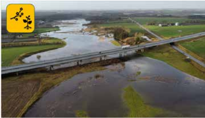
Figur 5: Den naturlige ådal umiddelbart opstrøms byen er rummelig og åen oversvømmer i våde perioder engene i ådalen. Dette forekommer naturligt i forbindelse med ekstrem afstrømning i vinterhalvåret. En sådan situation er vist på billedet. Med klimaprojektet opskaleres den naturlige vandtilbageholdelse i ådalen, for at skaffe magasineringsvolumen til 4,5 millioner kubikmeter ekstra vand. Vandet tilbageholdes 1 – 2 uger indtil vandet er ledt gennem byen i kontrolleret tempo.
