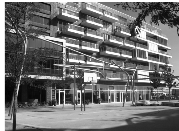
Husene, der grænser op til den eksisterende bymidte, er bygget med udkravning, mens resten af HafenCity er hævet til 8 meter over normalnul. For at sikre kontakten med vandet, er der lavet terrasser, der falder ned mod vandet, og hvor lamper og træer kan tåle jævnlige oversvømmelser. Sport er der også blevet plads til. Fotos: Torsten Bo Jørgensen
