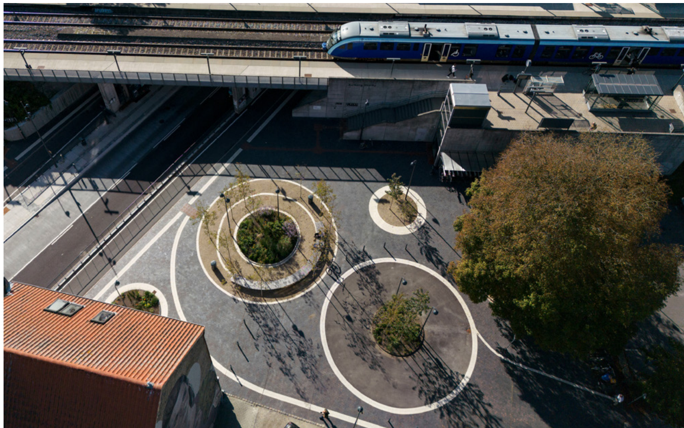
Aalborg Vestby Station. Kilde: Aalborg Kommune
