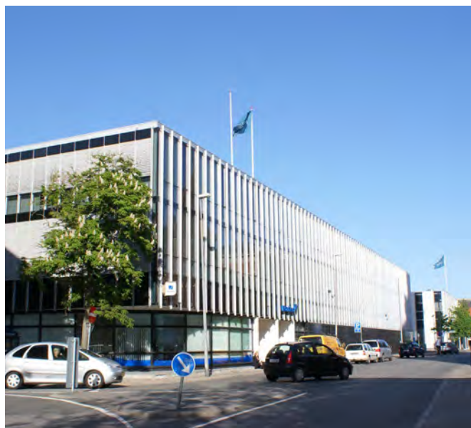
Budolfihus før omdannelsen. Kilde: Aalborg Kommune
