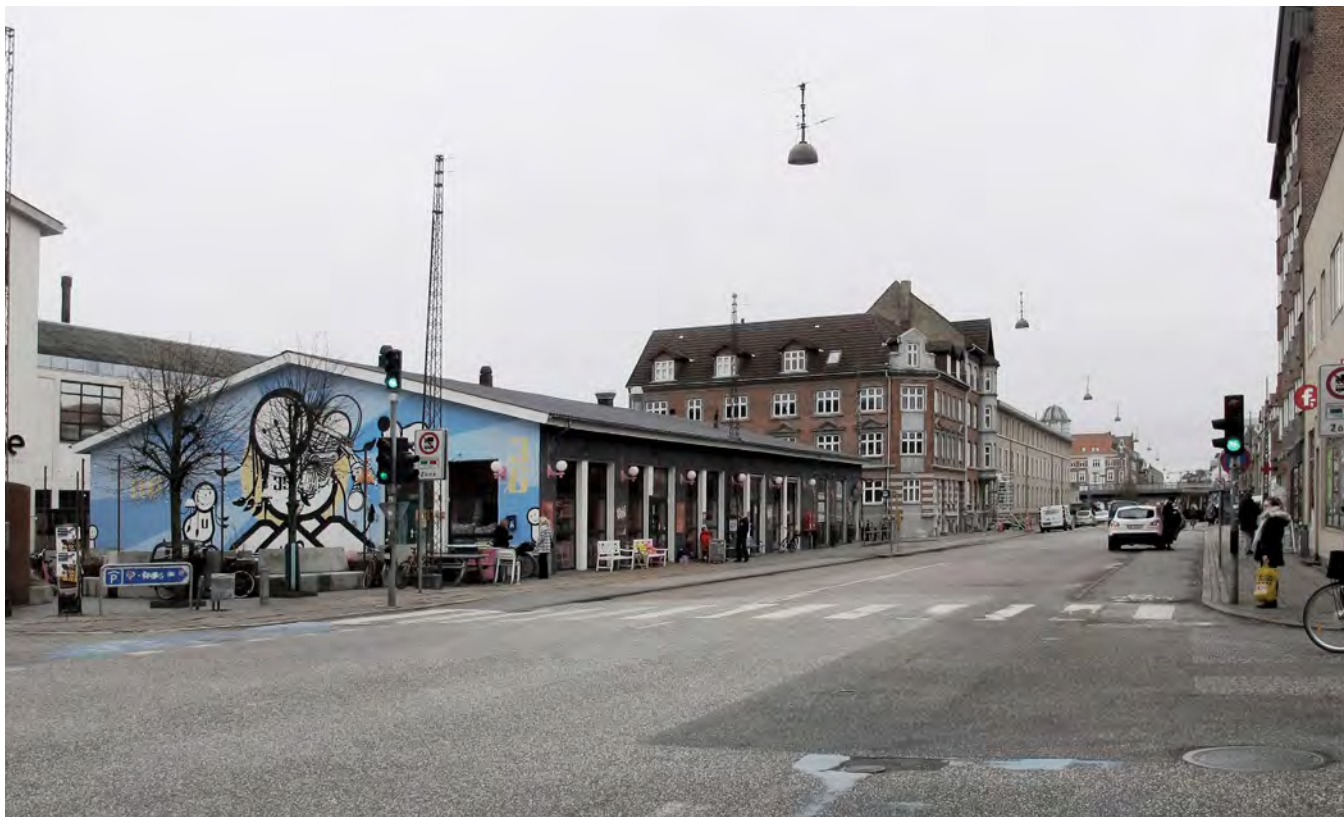
Kastetvej før ombygningen. Kilde: Aalborg Kommune
