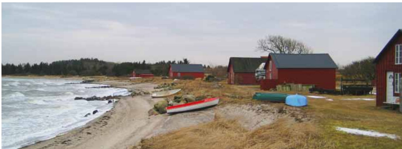
Et eksempel på kystfodring ved Humlum Fiskerleje. Før i tiden var stranden helt væk og bølgerne slog op under de røde skure. Siden hen blev der lagt sten ud som kystbeskyttelse og derefter fyldt sand på. Foto: Alberte Marie Danvig
