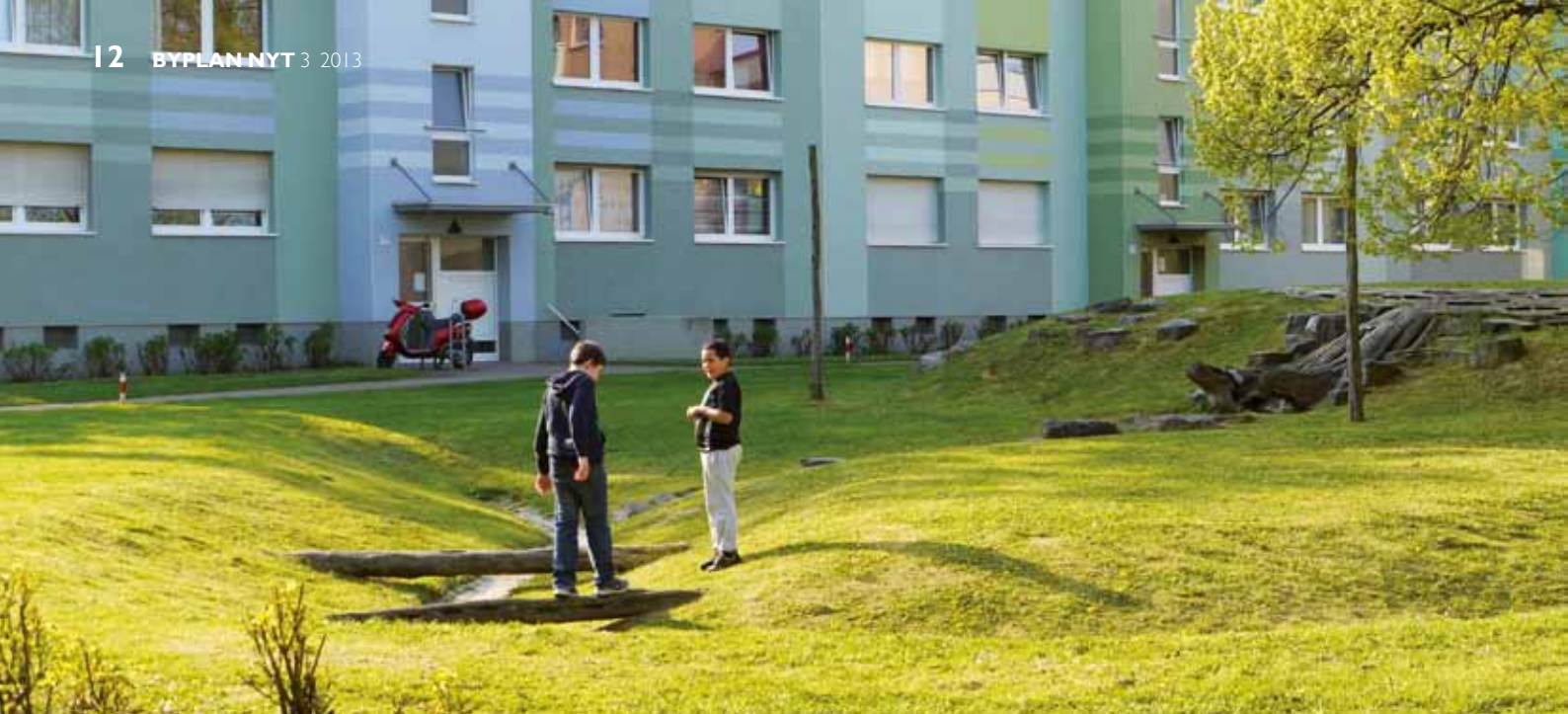
En legeplads i bydelen Scharnhorst Ost i Dortmund. Regnvand fra boligernes tage samles mellem bygningerne, hvor et landskab af kanaler, fordybninger og græsklædte bassiner pirrer fantasien og inspirerer til leg og bevægelse. Foto: Ny W. Øhlenschläger.
